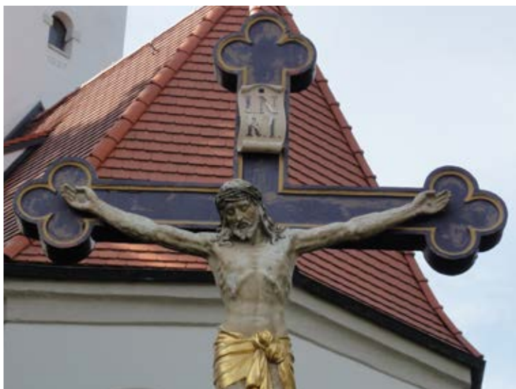
Schäden an der Farbfassung und Korrosionsschäden an Kreuz und Christuskorpus
