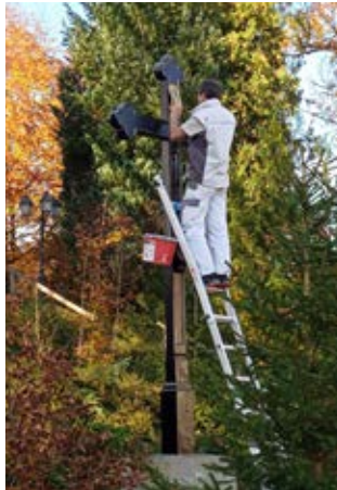
Auffrischen des Kreuzes – Oberflächenvorbehandlung durch Schleifen – 17.10.2024
