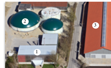
1) Hackschnitzelheizung, 2) Biogasanlage, 3) neuer Kuhstall
