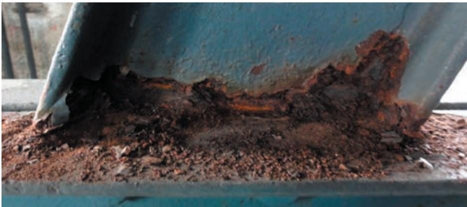
*Insbesondere zeigen die verschraubten Doppel-U-Profile eine umfassende Schädigung durch Spaltkorrosion. Das betrifft auch die Joche der Glocken und die Konstruktionselemente des Glockenträgers selbst.*
