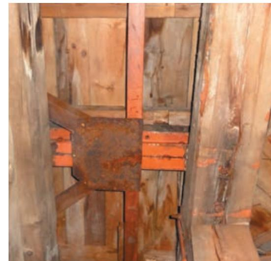
Verankerung der Stahlkonstruktion des Glockenstuhls auf der Holzkonstruktion des Unterbaus. Schädigung der Stahl- und Holzelemente infolge der eindringenden Feuchte bei fehlenden Schallländen
