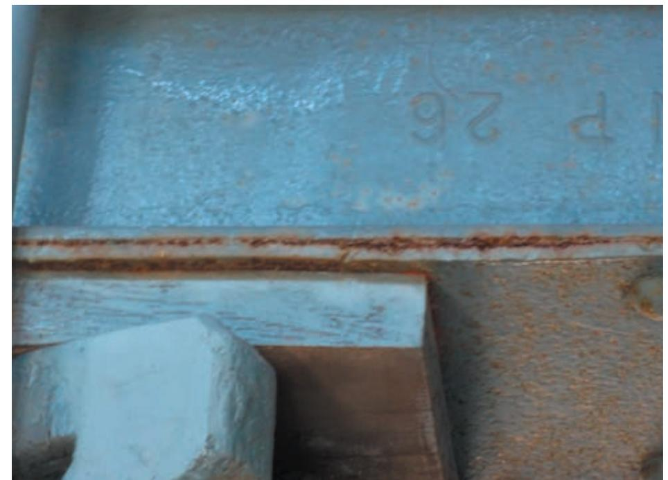
Die mittels Niet- und Schraubverbindungen realisierte Konstruktion der aus U-Profilen aufgebauten Stahljoche werden beim Läuten auf Torsion beansprucht. Aufgrund der starken des Jochs von Glocke 1 und deren großem Gewicht besteht die Gefahr des plötzlichen Absprengens der Schrauben und Nieten, was mit dem Versagen des Joches einhergehen kann.
