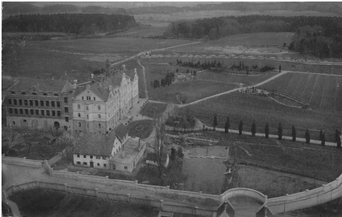
Locus structorius cum novo aedificio addito.
