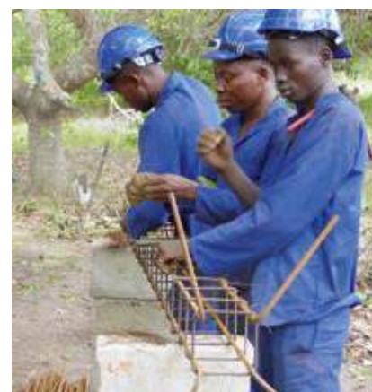
Bauarbeiten an der Neugründung
