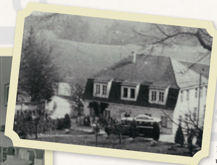
◀ ABTRANSPORT: Am 17. April 1941 mussten die Mönche in Bussen das Kloster verlassen. Das Foto wurde heimlich von einem Besucher aufgenommen
