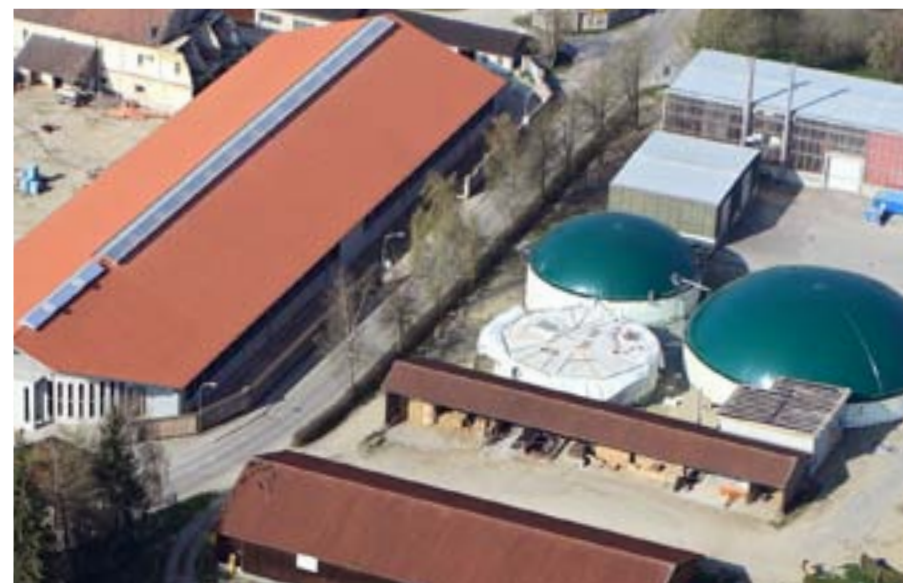
ENERGIEDREIKLANG: Milchviehstall (links), Biogas-Silos und Hackschnitzelheizung (oben) bestimmen das Energie-Geviert von St. Ottilien.
