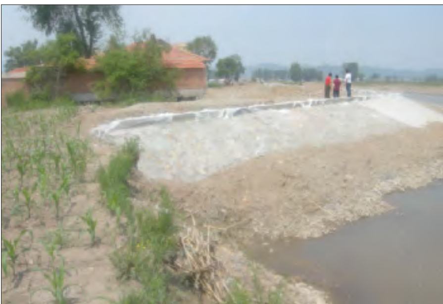
Ein befestigter Deich schützt vor der nächsten Flut.
