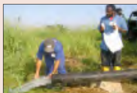
WASSER: Probebohrung auf dem neuen Grundstück
