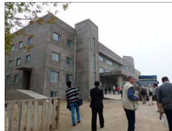
Der Rohbau wartet auf die Innenausstattung
