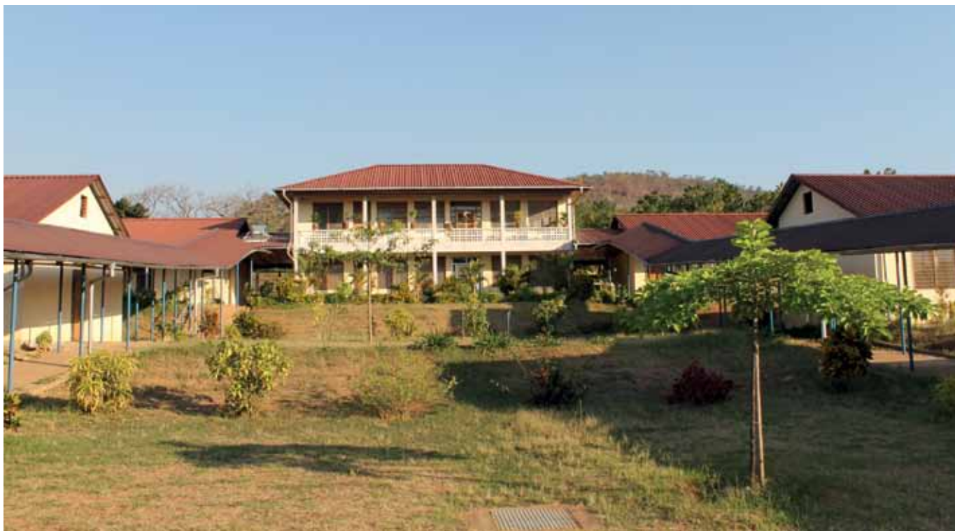
Das Einkehr- und Tagungshaus »Zakeo« (Zachaeus) des Klosters Ndanda. Vom zentralen Bau mit Tagungsräumen hat man einen schönen Blick auf die Baumsavanne. Seitlich ziehen sich Wohneinheiten für Kursbesucher den Berghang hinunter.
