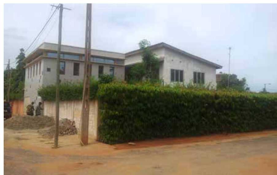
Bauarbeiten vor dem neuen Kloster
