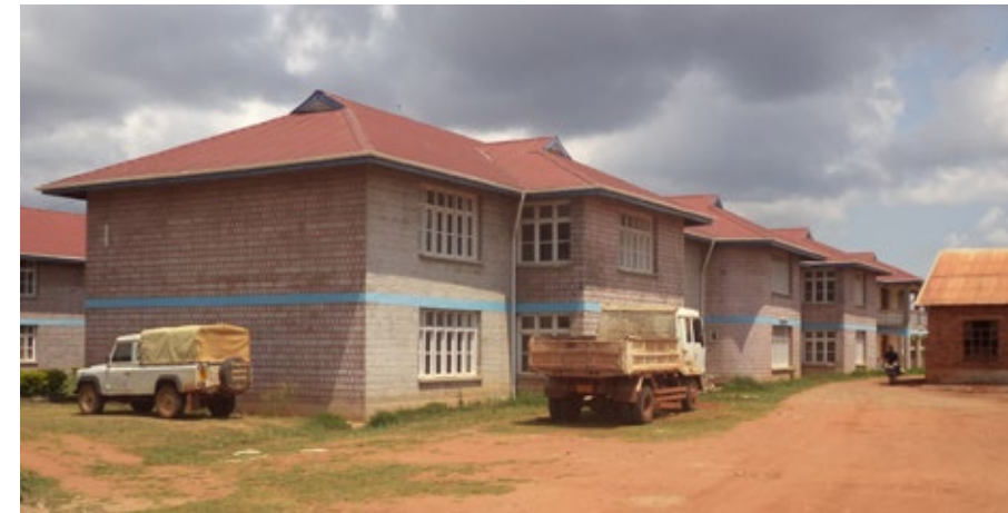
neues Konventgebäude in Hanga
