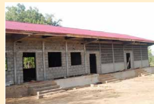
Neubau der Schule in Agbang für Computerraum und Bibliothek
