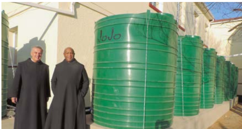
Wasser vom Dach: Zusammen mit dem Prior P. John Paul Mwaniki OSB konnte P. Maurus die neuen Regenwassertanks in Betrieb nehmen
