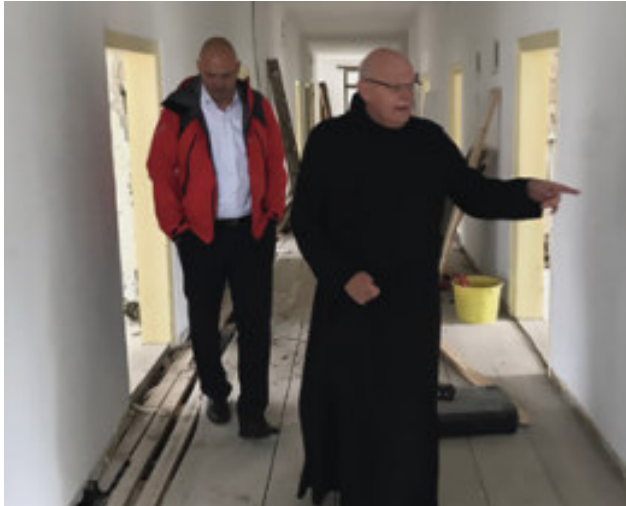
P. Prior Raphael Gebauer erkundigt sich nach dem Baufortschritt auf dem Georgenberg
