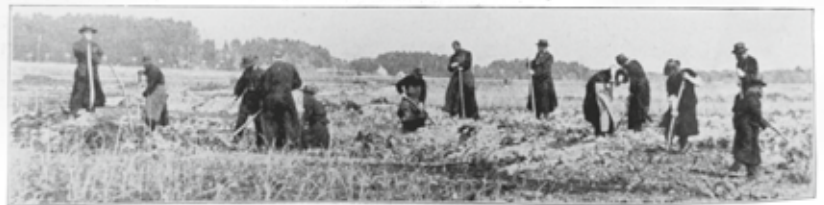
Patres und Kleriker beim Einfüllen der Drainagegräben im Emminger Weiher.
